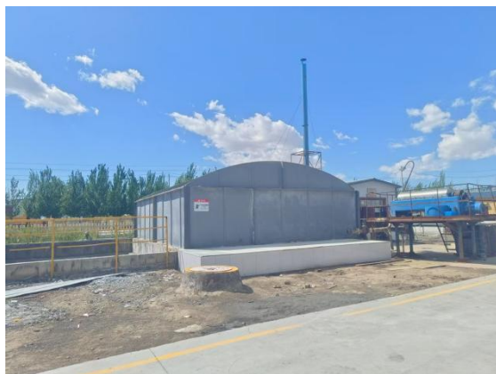
厂区污水处理站
