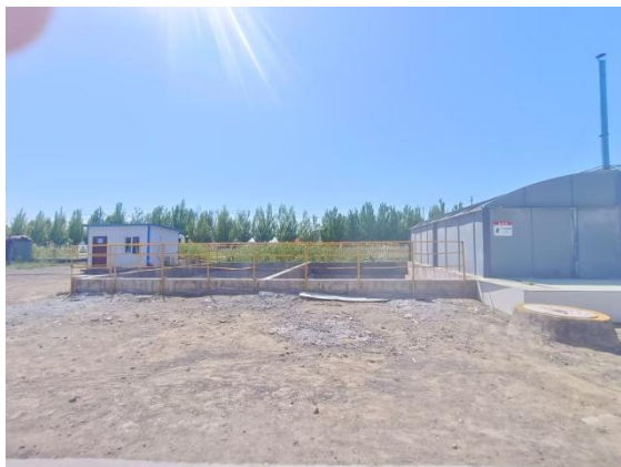
厂区事故水池
