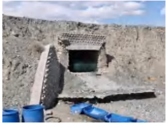
需改造涵洞及配水点
