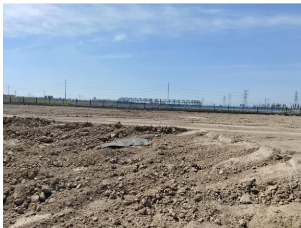
拟建变电站南侧
