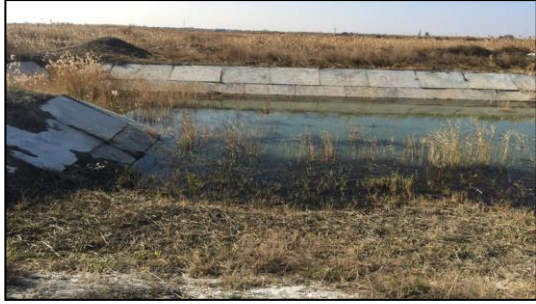
水库溢洪道泄
