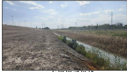
东坝坝后纵排
