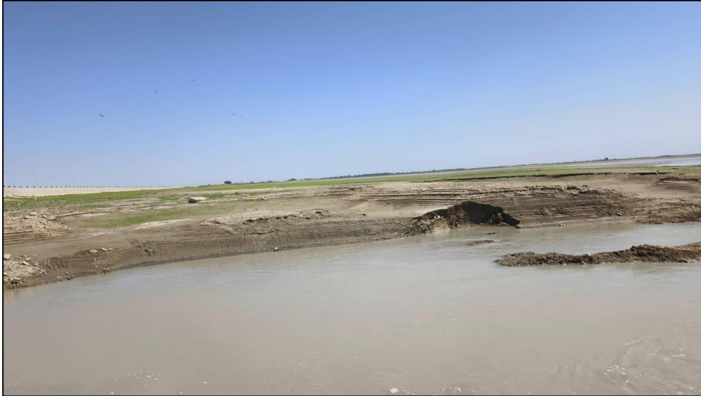
坝前库区淤积严重
