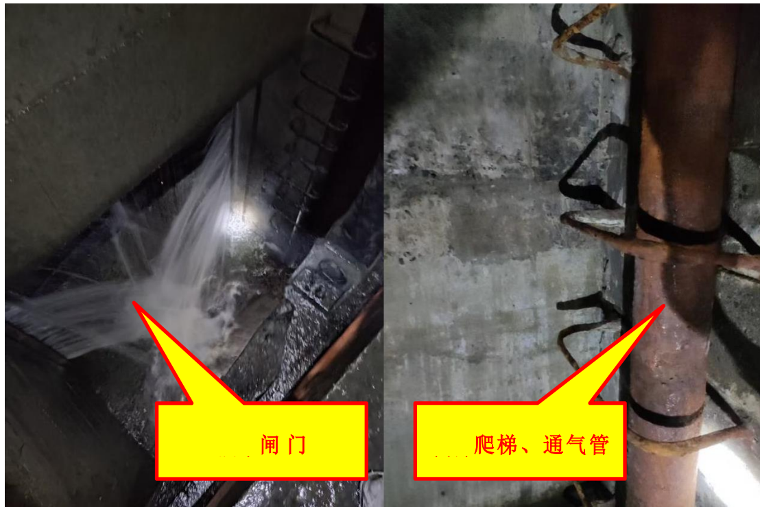
泄洪闸井口段
