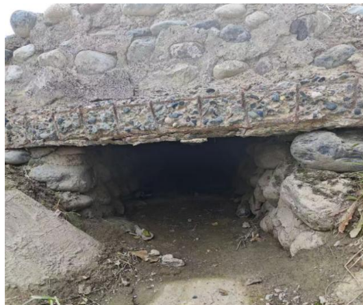
130 团 4 连输水渠建筑物
