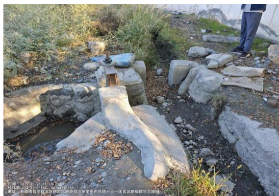
131 团 1 连东引水渠建筑物
