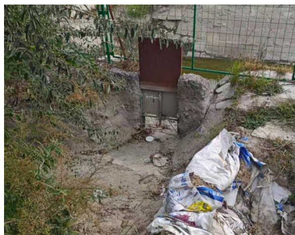
131 团 11 连西六输水渠建筑物
