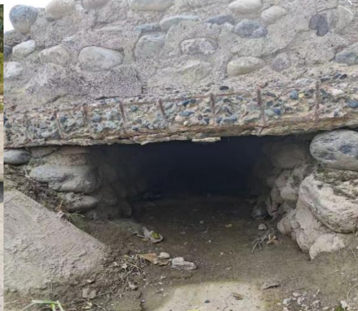
130 团 4 连输水渠建筑物现状图
