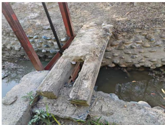
130 团 1 连输水渠建筑物
