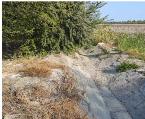
131 团 1 连东引水渠现状图
