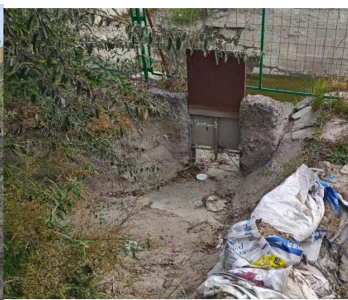
131 团 11 连西六输水渠建筑物现状图
