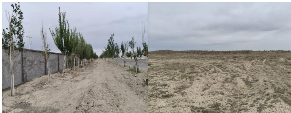
110kV 晶诺二期变至晶电变线路
